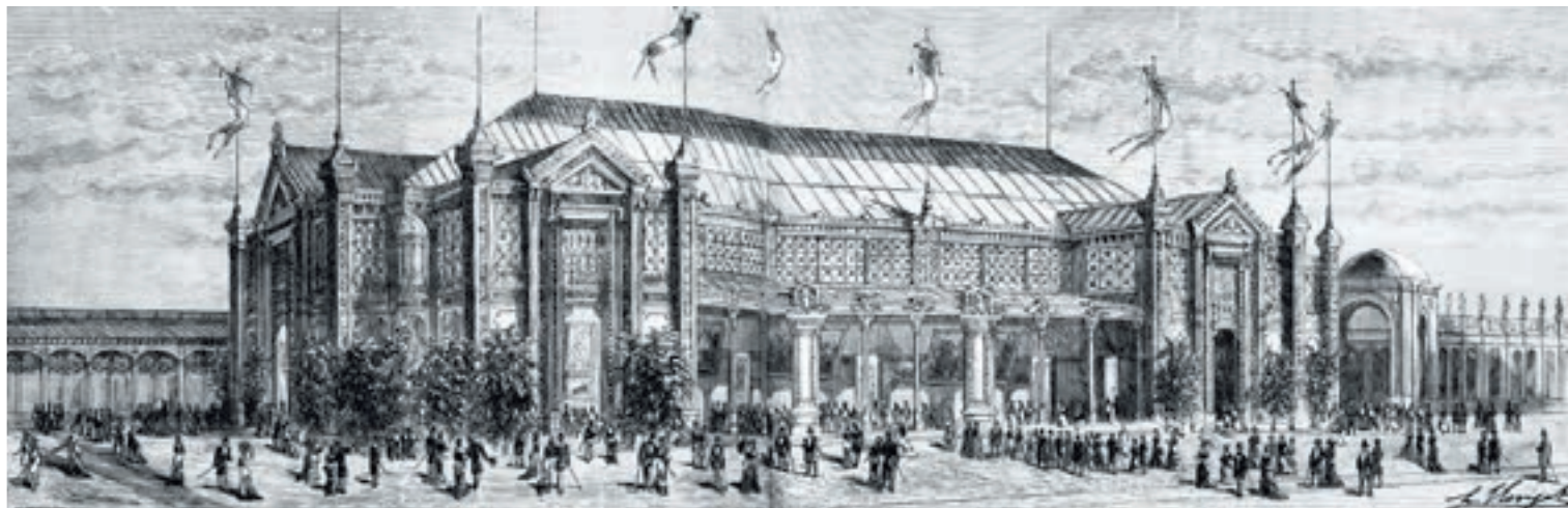
Le pavillon de la Ville de Paris au centre du Palais du Champ-de-Mars M. Bouvard, architecte Exposition universelle de 1878
