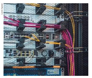
l'ensemble du local est climatisé afin d'éviter une surchauffe des installations. Mais un data center cloisonné permet de ne refroidir que quelques mètres cubes d'air (dans notre cas ceux de l'allée centrale au milieu des armoires) et de reieter l'air chaud à l'arrière. Le free cooler permet quant à lui de récupérer l'air froid extérieur une grande partie de l'année afin de ne pas enclencher le système de climatisation qui est extrêmement éneraivore.»
