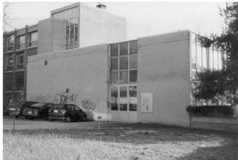
Le bâtiment de l'av. des Bains 21 est une construction typique des années '60: construction en béton armé, façades en aluminium, verre et béton lavé.
